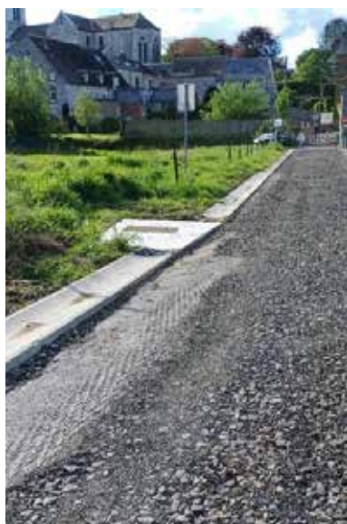
Travaux préparatoires par le service communal
