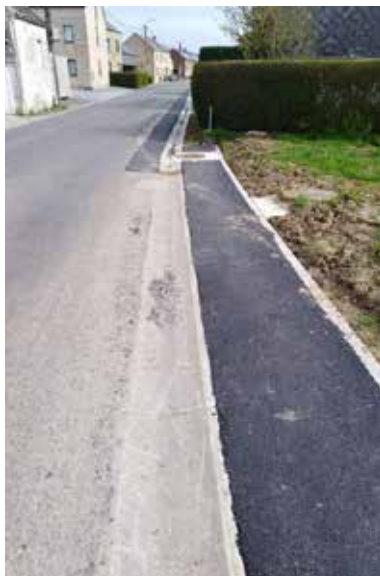
Trottoir prolongé rue de l'Abbaye
