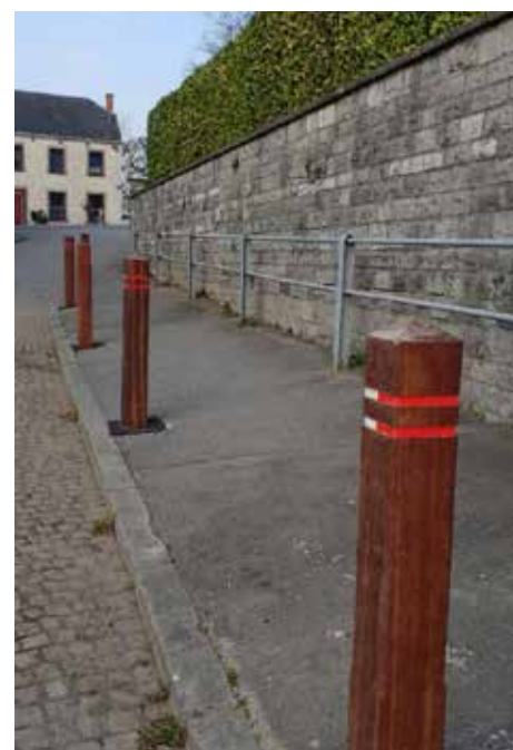
Sécurisation des piétons, Place communale
