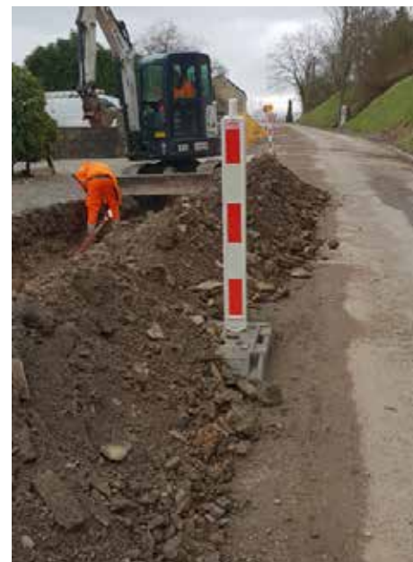
Durant les travaux, rue Pirauchamps
